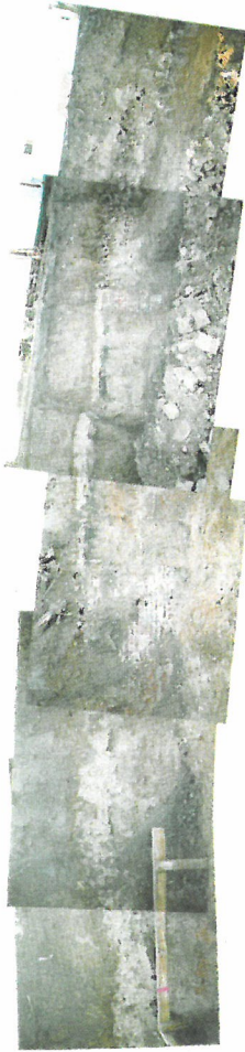
47 Mauerreste des Benrather Marstalles, des sog. „Prinzenstalles“ entlang der Südgrenze des Grundstückes Schlossallee 121, 1999.
