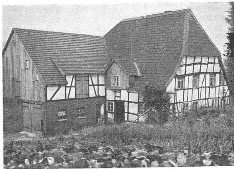
„Dicke“ in der Bürgermeisterei Kürten. Stammhof des Altes Broichhaus
