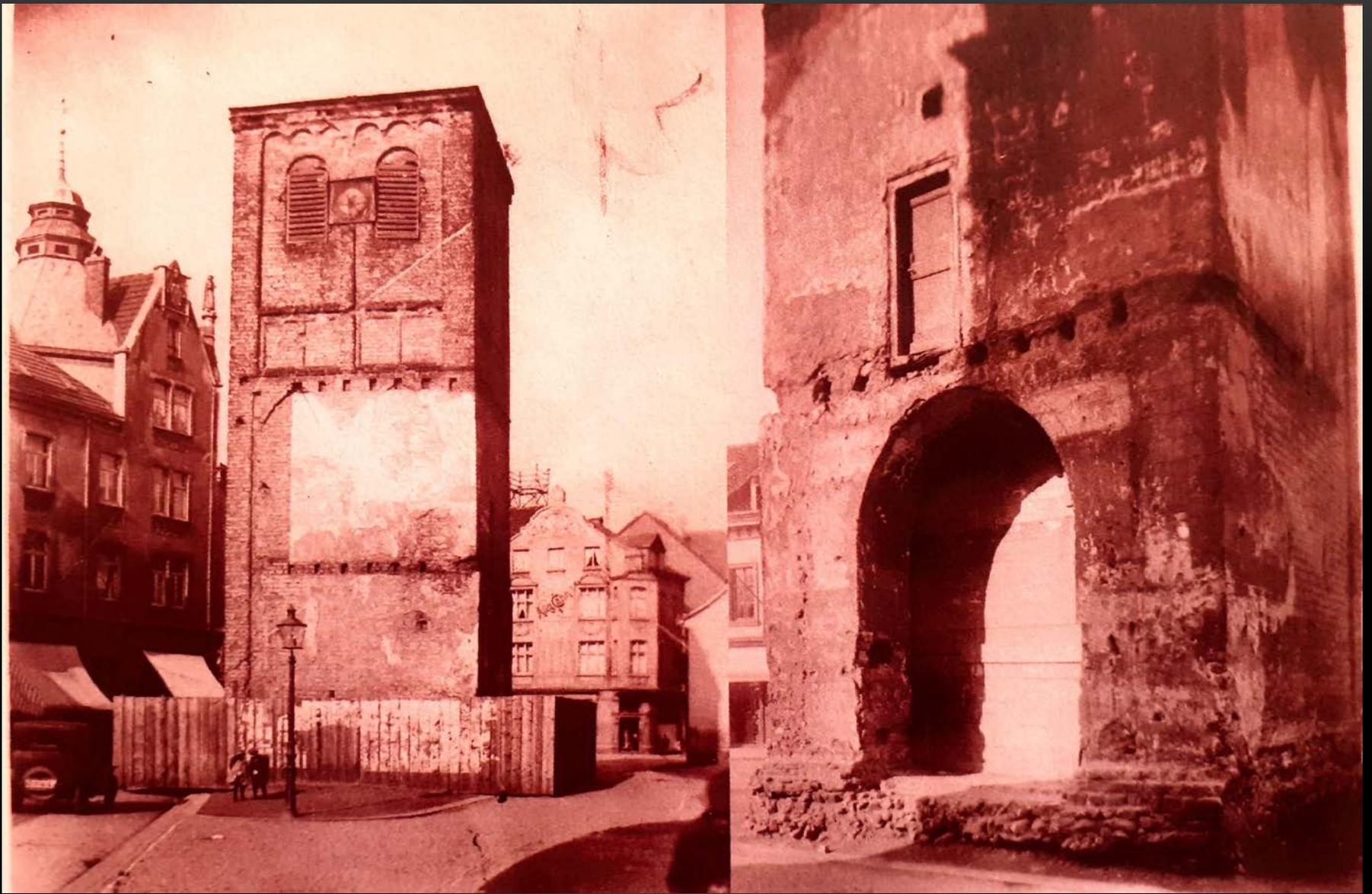
1922 Der Turmhelm musste abgebrochen werden. Die Benrather Zimmerei Müller sicherte den Turm durch ein Notdach. Der Plan eine Kriegergedächtnisstätte einzurichten wurde durch die Inflation aufgegeben.
